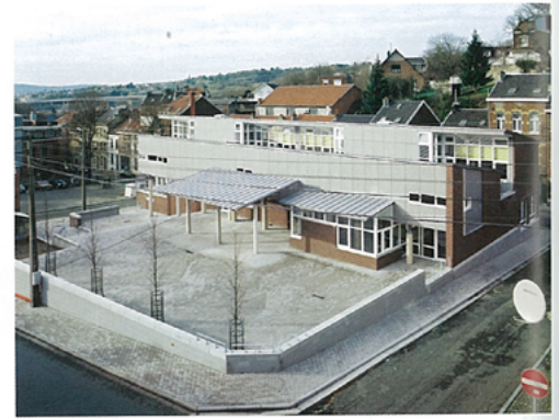
depuis la place, on accède naturellement au terrain de l'école
